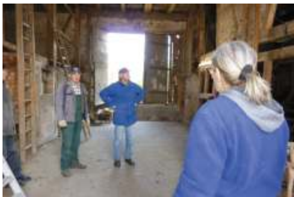
Alte Backsteine und Siebschutt werden im Kellerloch eingebracht und verdichtet
